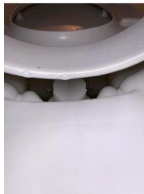
Distributeur de rinçage, dans la partie arrière de la céramique, là où l'eau se répartit à droite et à gauche de la céramique:
